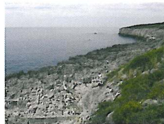
Vista da Rechã talhada no calcário, aprox. 7 m acima do nível do mar.
