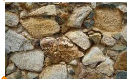
Fig. 4 - Casa antiga construída em alvenaria de pedra natural. A – Fachada da casa. B - Pormenor da parede exterior construída em alvenaria de pedra natural (vários tipos de rochas locais – sienito nefelínico, grauaque, xisto argiloso).
