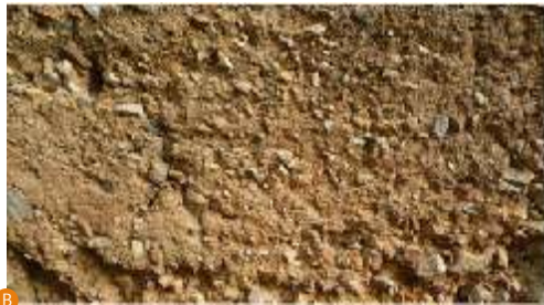
Fig. 13 - Ruína construída com a técnica da taipa. A – Aspeto geral da ruína. B – Pormenor de uma parede exterior construída em taipa (terra compactada).
