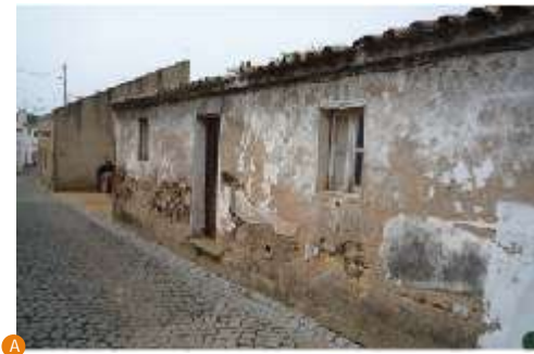
Fig. 5 - Antigo lagar (rua Inácio Cabrita) construído em alvenaria de sienito. A – Aspeto geral do edifício. B – Pormenor das paredes construídas com blocos de sienito nefelínico, podendo-se identificar um xenólito (fragmento de rochas pré-existentes incluído noutra rocha) de uma rocha mais escura.
