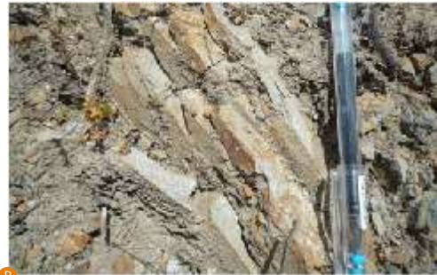
Fig. 13 - Ruína construída com a técnica da taipa. A – Aspeto geral da ruína. B – Pormenor de uma parede exterior construída em taipa (terra compactada).
