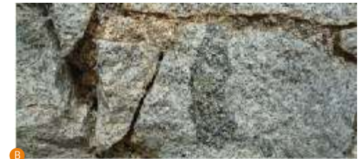
Fig. 5 - Antigo lagar (rua Inácio Cabrita) construído em alvenaria de sienito. A – Aspeto geral do edifício. B – Pormenor das paredes construídas com blocos de sienito nefelínico, podendo-se identificar um xenólito (fragmento de rochas pré-existentes incluído noutra rocha) de uma rocha mais escura.
