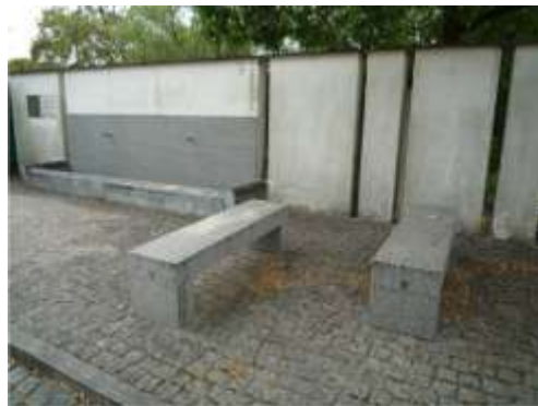
Fig. 2 - Bebedouro recuperado com sienito nefelínico homogéneo na rua Inácio Cabrita.
