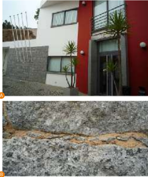
Fig. 8 - Junta de freguesia de Marmeleite. A- Evidencia-se o revestimento das paredes e as cantarias de sienito nefelinico homogéneo. B- Pormenor dos blocos de sienito da parede, onde se evidencia a diferença na granularidade (tamanho dos cristais) entre o bloco de cima, com granularidade mais fina, e o bloco de baixo, com granularidade mais grosseira.
