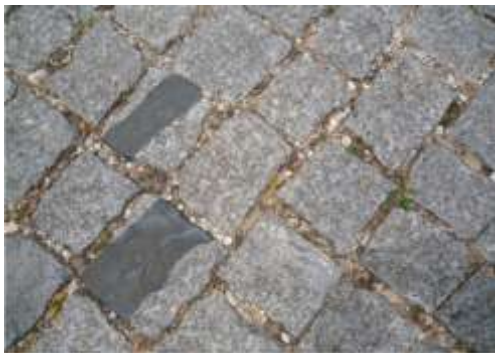
Fig. 1 - Pormenor da calçada das ruas de Marmeleite, observando-se os cubos de sienito nefelínico homogéneo; alguns cubos apresentam faixas de uma rocha negra (filões de rochas magmáticas básicas).
