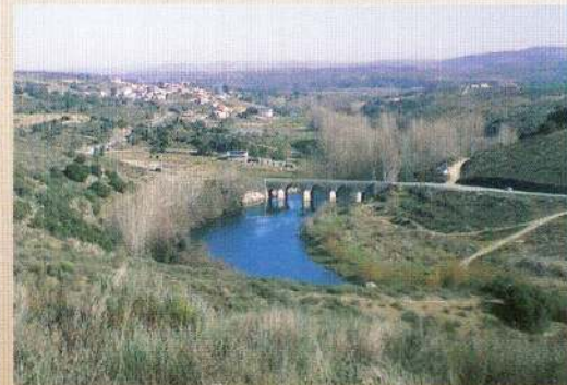
Ponte da Formigosa
